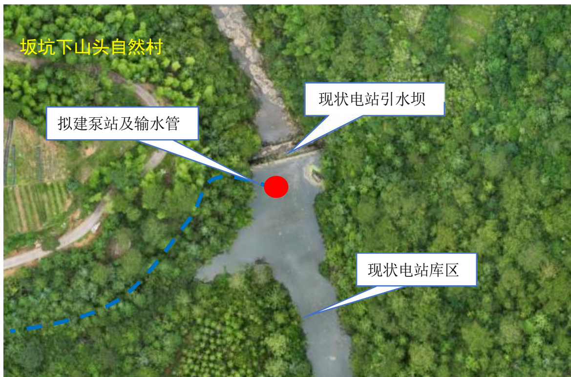
图 2.2.5-3 拟建坂坑溪浮筒取水泵站
